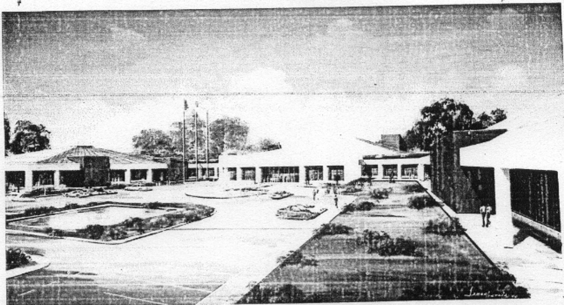
Planta Texas Instruments. Arquiter Internacional; José Antonio Garagarza Corona. Aguascalientes, Aguascalientes, México. 1995-1997.
