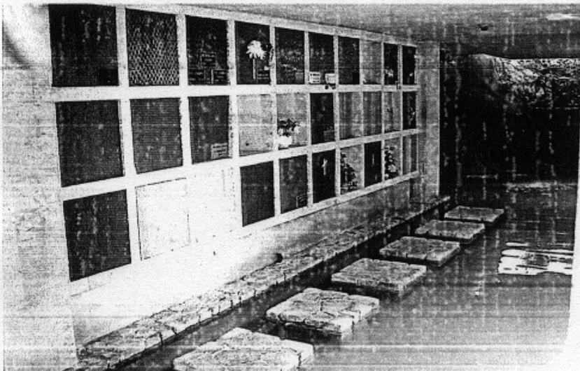
Capilla Ecuménica La Paz. Fray Gabriel Chávez de la Mora, Jorge Madrigal. Las Brisas, Acapulco, Guerrero, México. 1971.
