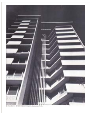
CONDOMINIO EN MIRAMAR, SANTURCE foto de www.arquitectura411.com
