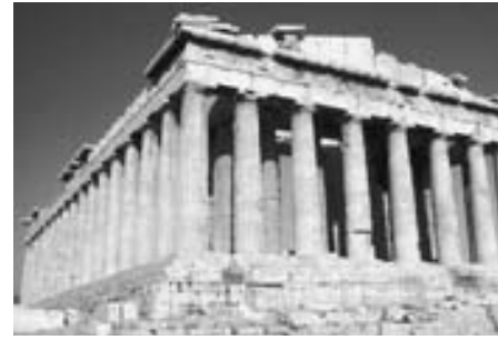
FIGURA 12-17 Este templo griego (en Agrigento, Sicilia) fue construido hace 2500 años y muestra la construcción con postes y vigas. Las columnas están bajo compresión.
