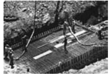
FIGURA 12-22 Varillas de acero alrededor de las cuales se vierte concreto para lograr resistencia.
