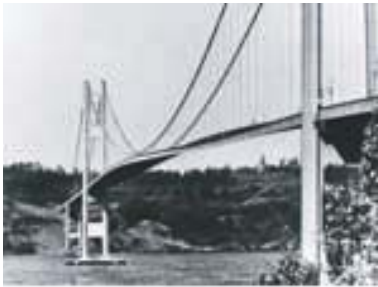
FIGURA 14-25 a) Oscilación de gran amplitud del puente Tacoma Narrows, debido a ráfagas de viento, que condujeron a su colapso (1940). b) Derrumbe de una autopista en California, causado por el sismo de 1989.
