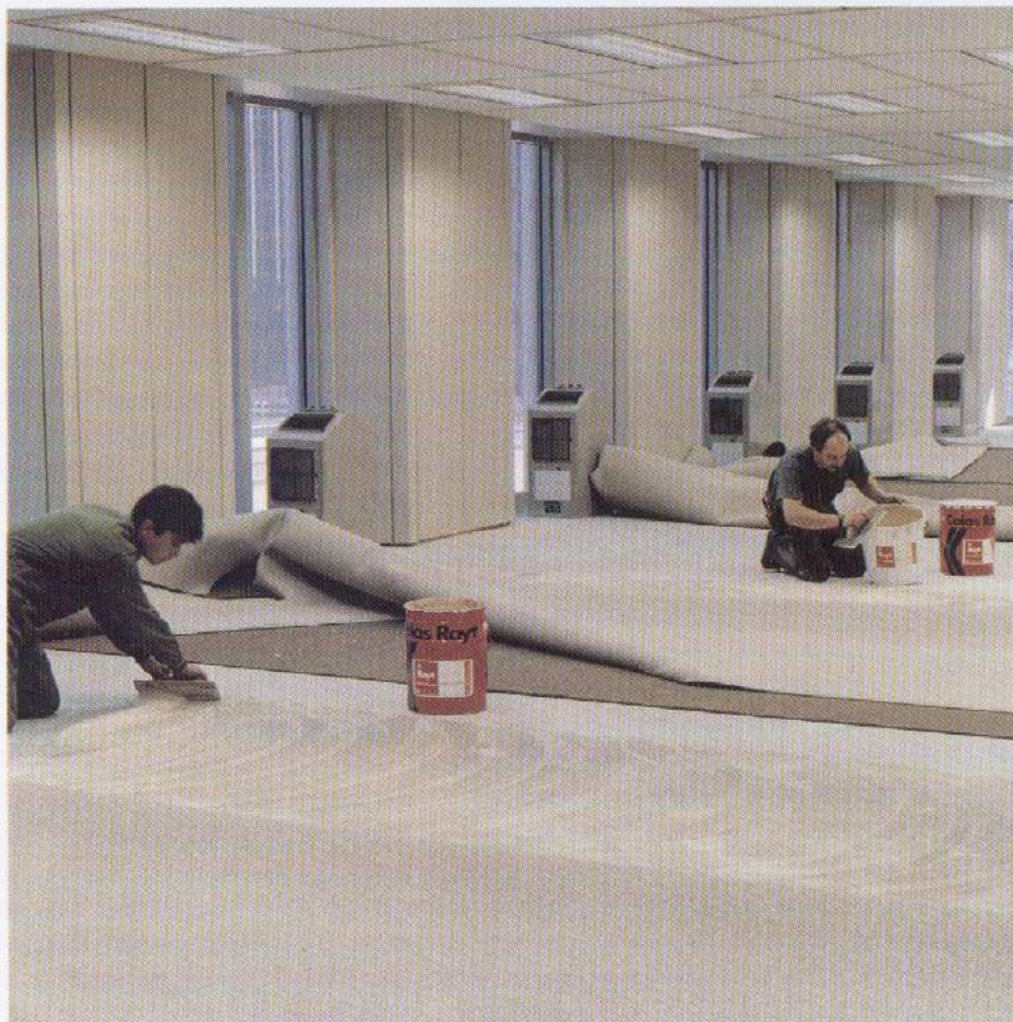
Aplicación de adhesivos para acabados sintéticos
