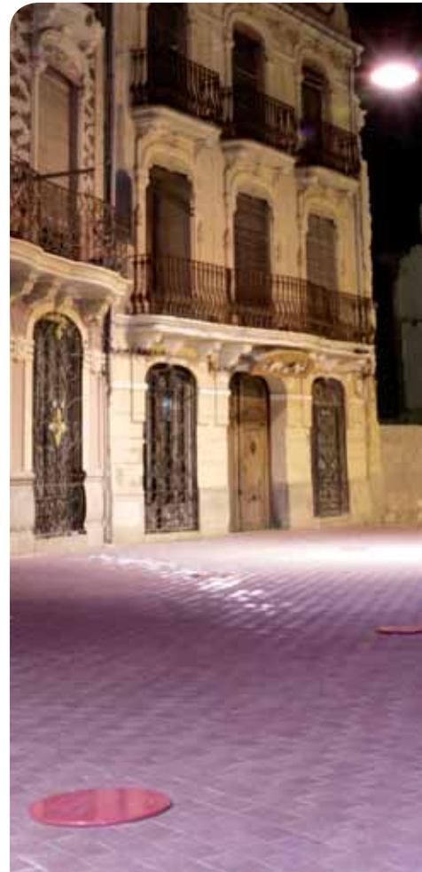
FOTOGRAFÍA 2.1. Calle San Vicente, Burriana (Castellón).
