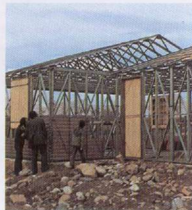
Ventanas y puertas prefabricadas sobre estructura metálica
