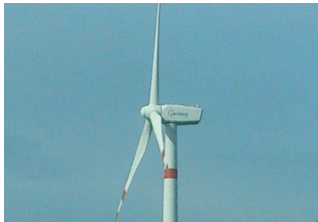
Fig. VII.1. Aerogenerador en México, bajo el control de CFE
