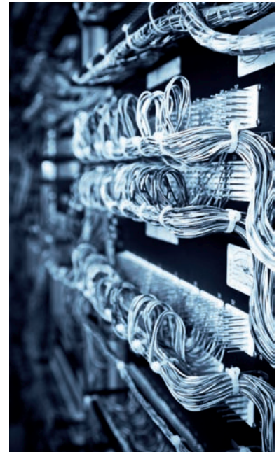
2.5. Cableado, agrupado por abrazaderas, en un CPD.
