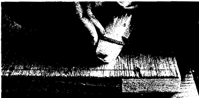
El tirafondo penetrará fácilmente si se lubrican sus hélices. Este lubricado se conseguirá con parafina o cera, ya que el uso de un aceite podría dar lugar a manchas inconvenientes.
