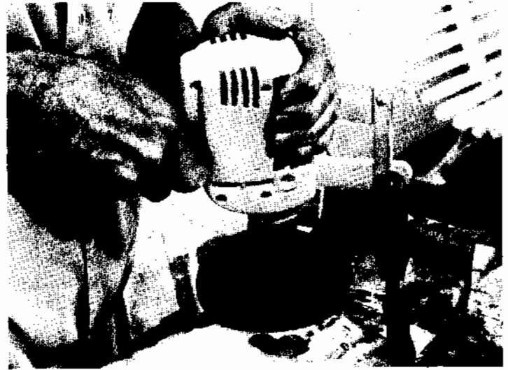
Lijado de la superficie después de haber arrancado la mayor parte de la chapa. Se utiliza para el caso un disco blando de lijar con papel de grano medio. No hay que dejar entretenida la máquina sobre un mismo punto sino imprimirle un constante movimiento de un lado para otro.
