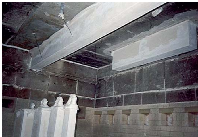
Ensayo de vigas y pilares protegidos con placas
