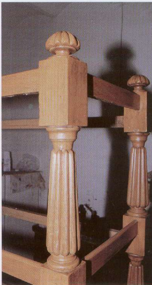
Veladura grasa ya barnizada.
