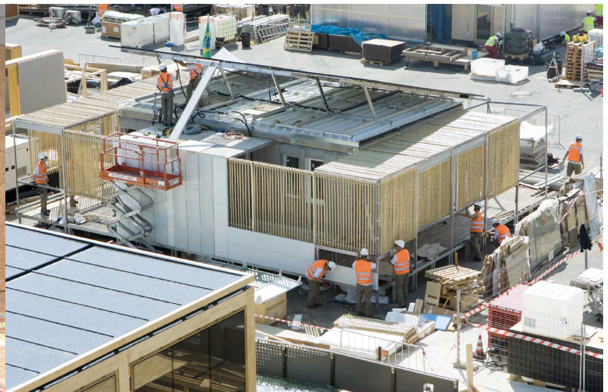
Figura 5: Construção da Ekó House em Madrid pelos estudantes brasileiros
