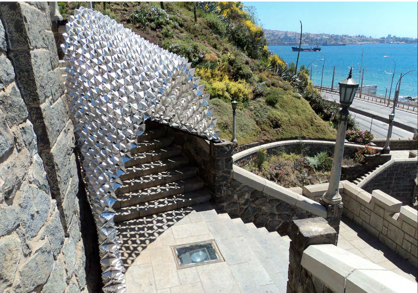
Fig.8. Vista Lateral de la Instalación Finalizada.
