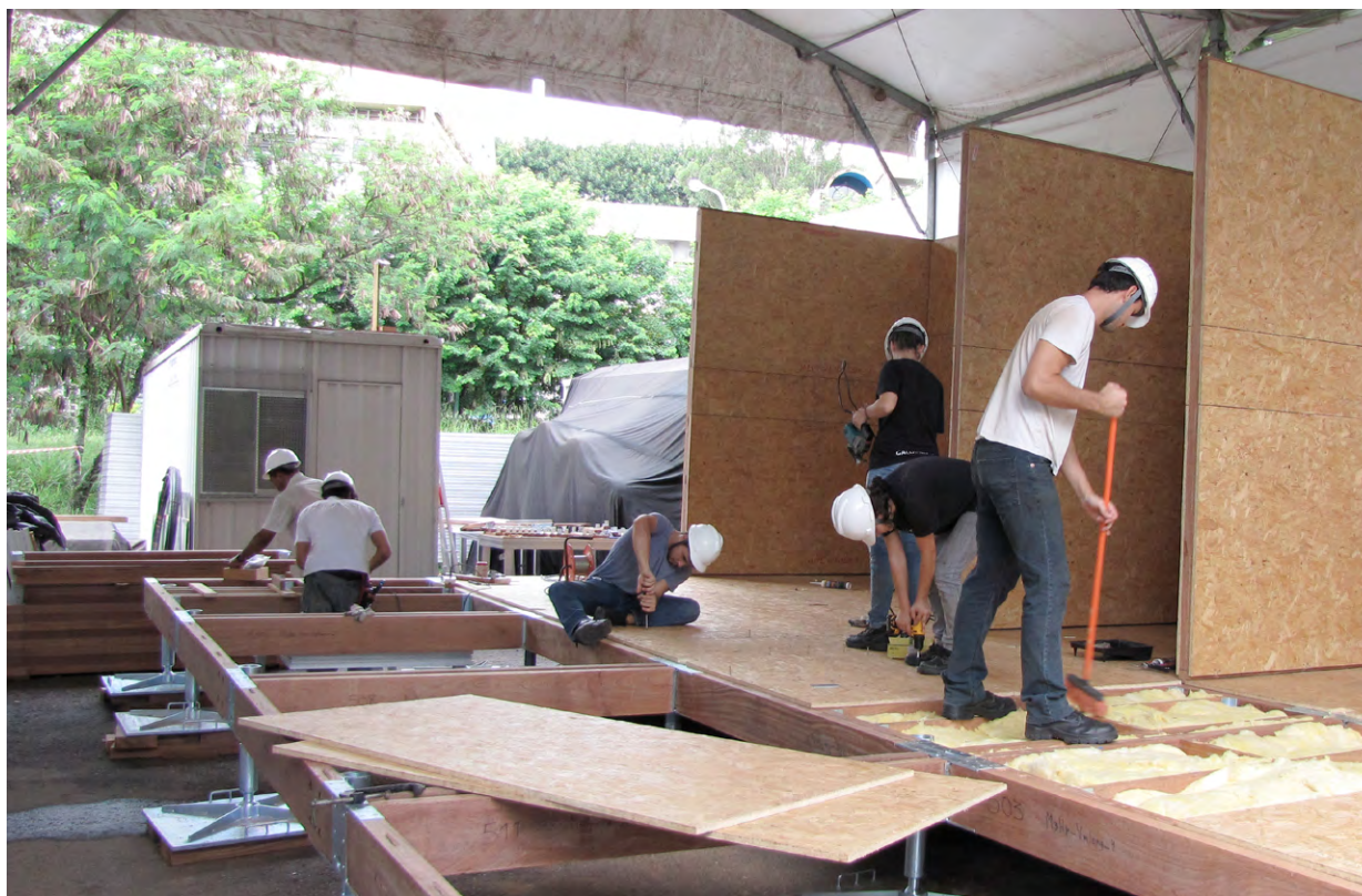
Figura 4: Construção da Ekó House no IEE-USP, 2011
