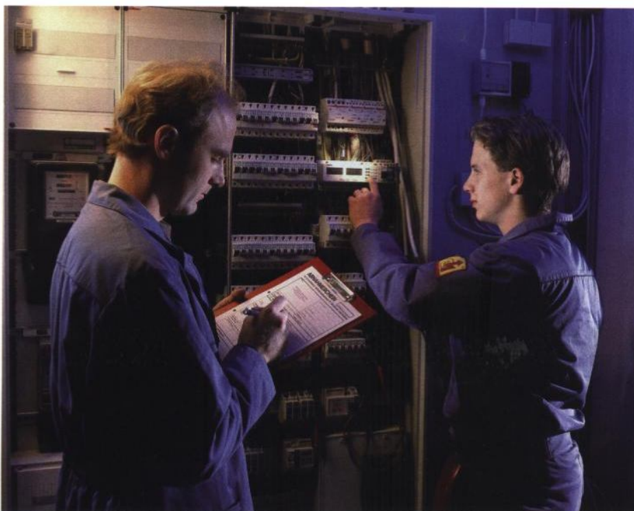
↑ Revisión de una instalación eléctrica.
