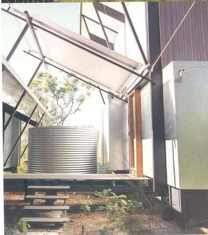
**INFERIOR** La vivienda se autoabastece con agua de la lluvia, que cae de los tejados y se almacena en depósitos colocados entre cada módulo.
