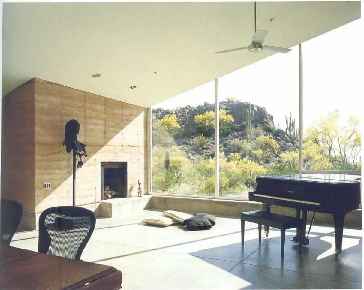
**SUPERIOR** Los suelos de la vivienda son de cemento pulido, y el techo desciende hacia la chimenea central, que tiene dos hogares, uno interno y otro que da al porche.
