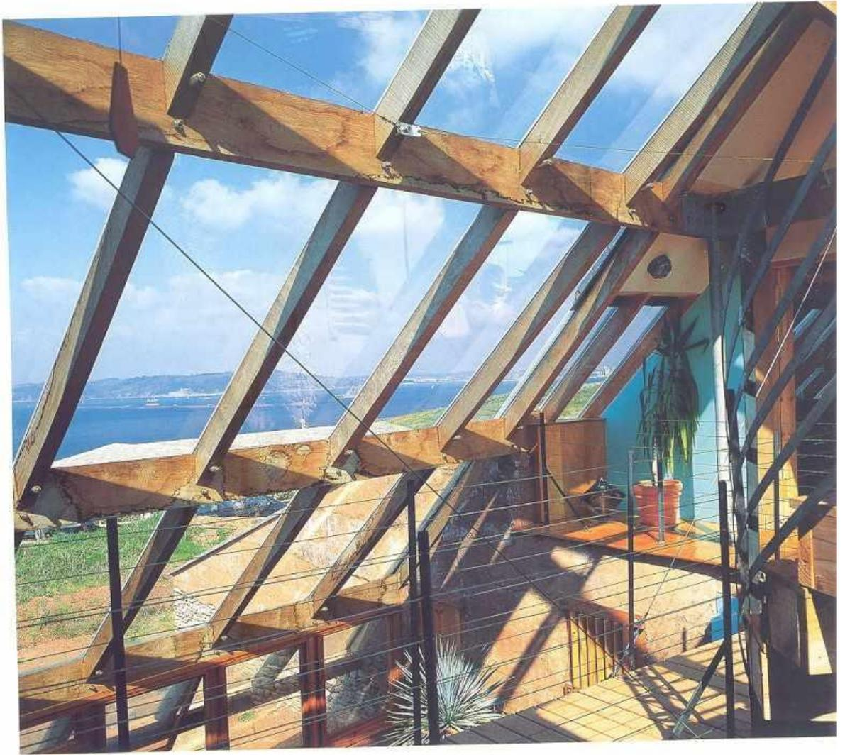
**SUPERIOR** La estructura superior está construida con madera de roble, rigidizada con cables y tensores de acero inoxidable procedentes del sector náutico.
