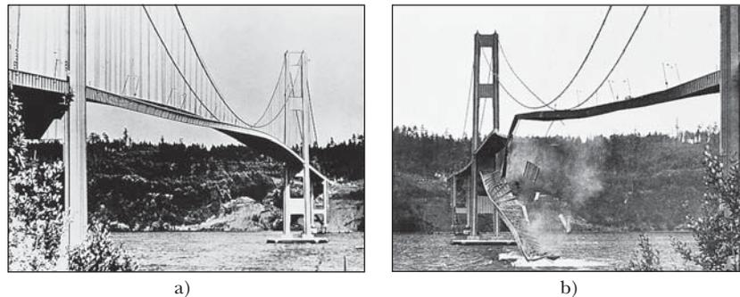
**Figura 15.24** a) En 1940 vientos turbulentos establecieron vibraciones de torsión en el puente Tacoma Narrows, haciendo que oscilara a una frecuencia cercana a una de las frecuencias naturales de la estructura del puente. b) Una vez establecida, esta condición de resonancia condujo al colapso del puente. (UPI/Bettmann Newsphotos)
