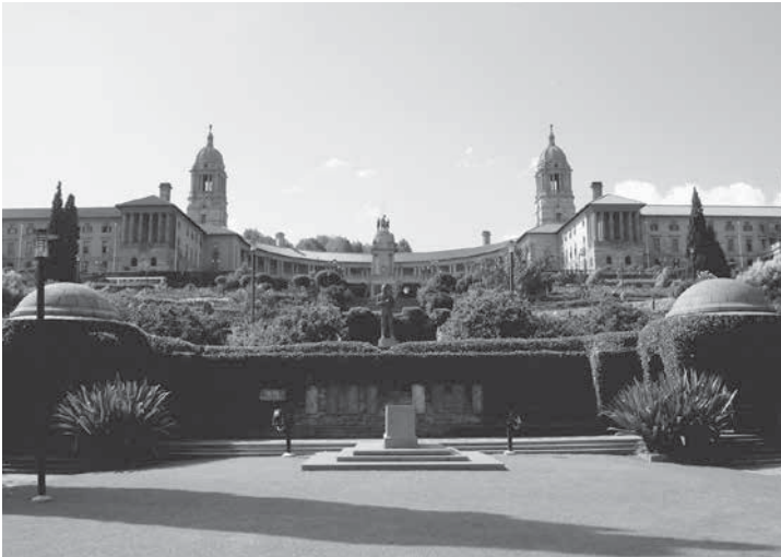
5.86 Casa del gobierno y edificios federales en Pretoria, Sudáfrica
