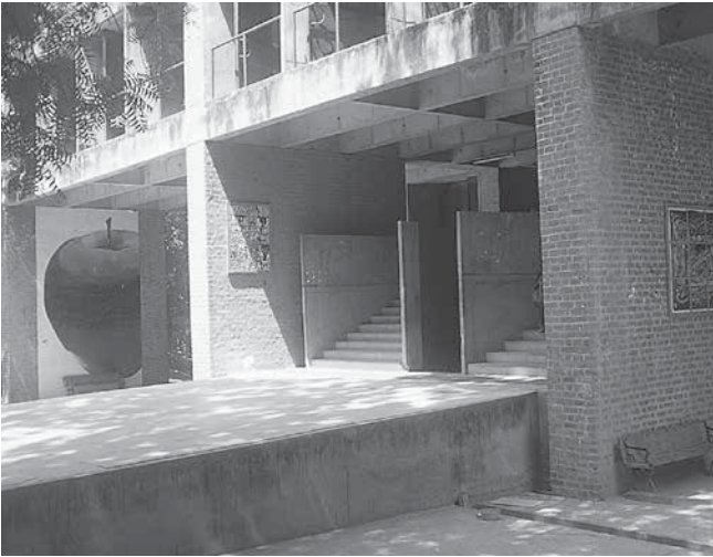
6.143 Escuela de Arquitectura, Ahmedabad, India
