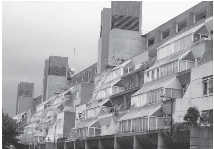
6.138 Edificio del Foundling Estate, Londres, Reino Unido
