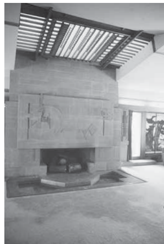
5.116 Casa Hollyhock: chimenea
