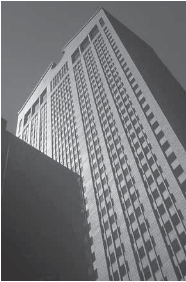
6.151 Edificio AT&T, Nueva York, Estados Unidos
