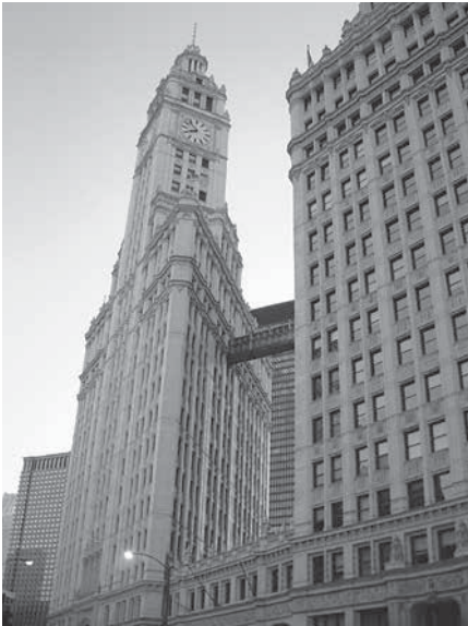
5.62 Edificio Wrigley, Chicago (Illinois), Estados Unidos
