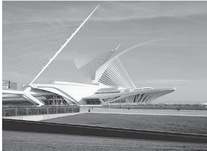
7.3 Santiago Calatrava, pabellón Quadracci del Milwaukee Art Museum, Estados Unidos
